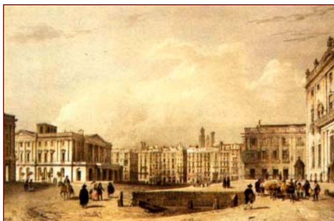
El Pla de Palau durant les obres d'urbanització del segle XIX
